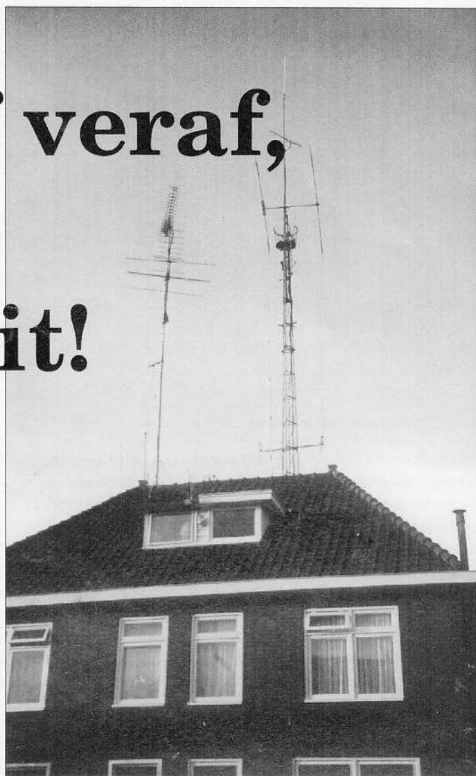
De trots van Johan: zijn antenne op een hoogte van ruim dertig meter.
